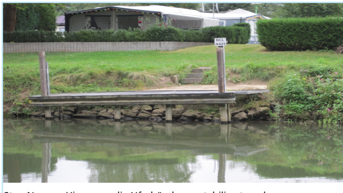
Steg Nassau. Hier muss die Uferböschung stabilisiert werden.
