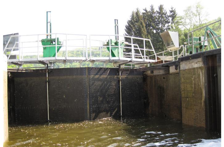
Höchst erfreulich: Schleuse Scheid - neue Tore, neue Antriebe, sanierte Wände.
