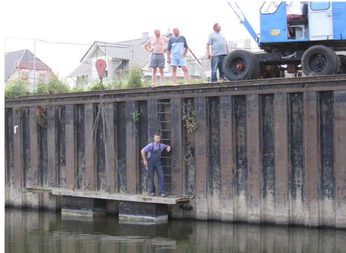
Erste Überlegungen für den geplanten Notsteg an der Spundwand.
